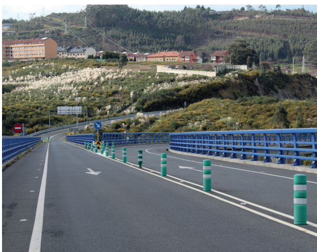
Figura 13. Elementos de balizamiento como refuerzo para separación de sentidos en vía de alta capacidad. Fuente: elaboración propia
