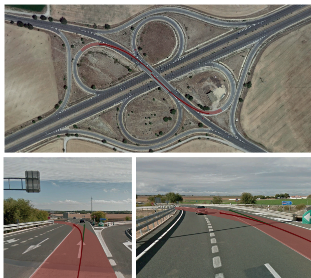
Figura 25. Enlace tipo trébol sin separación física de sentidos en la vía principal. Fuente: Google Earth, 2018
