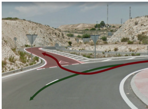
Figura 29. Acceso sin señalización vertical de prohibido el paso. Fuente: Google Earth, 2019
