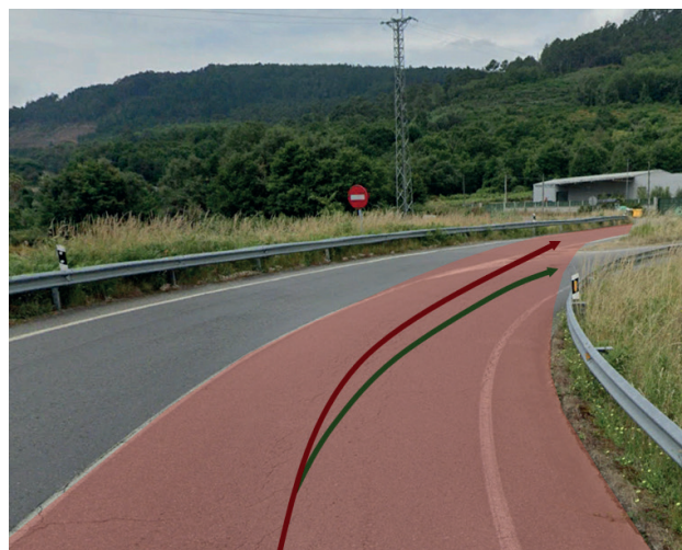
Figura 21. Enlace tipo trompeta sin separación física, sin refuerzo de señalización vertical y marcas viales en mal estado de conservación. Fuente: Google Earth, 2019
