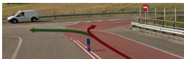
Figura 18. Geometría y balizamiento en enlace tipo diamante. Fuente: Google Earth, 2016
