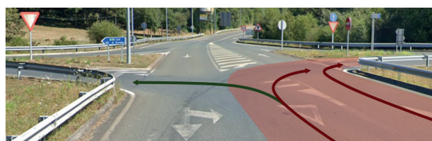
Figura 17. Señal R-101 sin refuerzo y difícil de percibir por parte del usuario. Fuente: Google Earth, 2021
