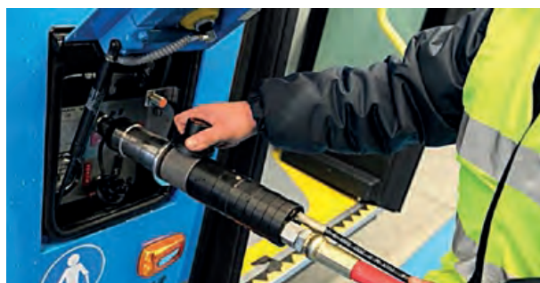
Boca de llenado GNC en un autobús
