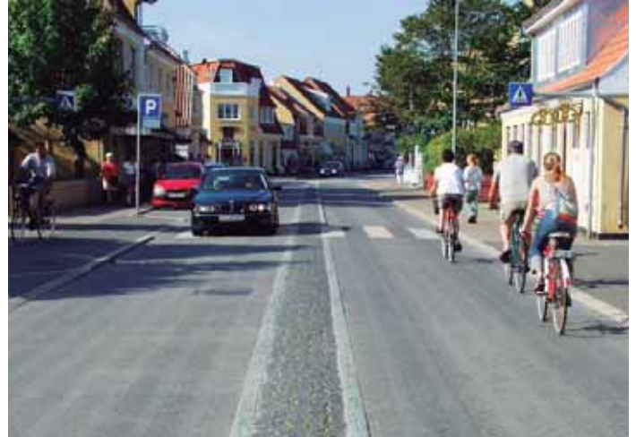
Estrechamiento ligero de los carriles de circulación mediante una mediana rugosa en Dinamarca. Fuente: Vejdirektoratet
