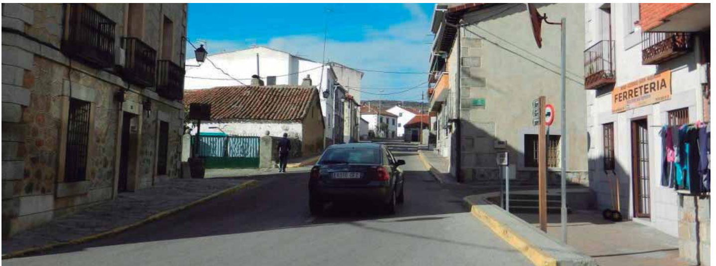
Tramo con aceras de insuficiente dimensión, con obstáculos insalvables y escalones
