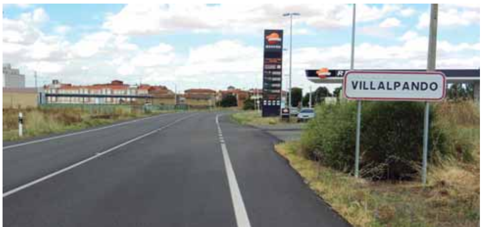
Señal de travesía a varios cientos de metros de las edificaciones.
