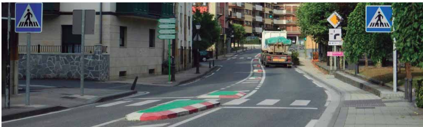
Estrechamiento mediante pintura y refugios peatonales.
