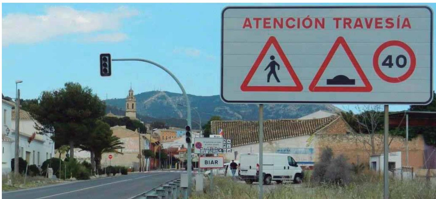
Señalización conspicua de travesía que “invisibiliza” la señal convencional.
