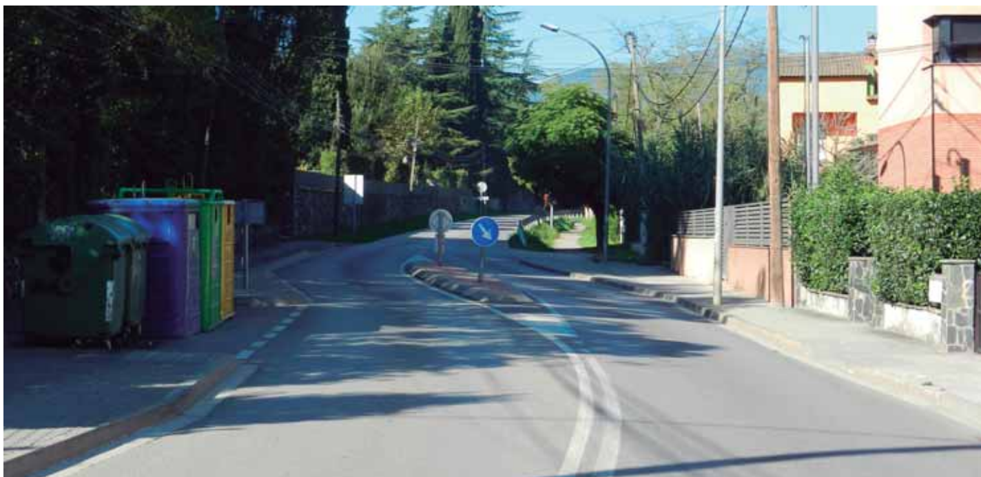
Desvío de la trayectoria en el acceso a una travesía.
