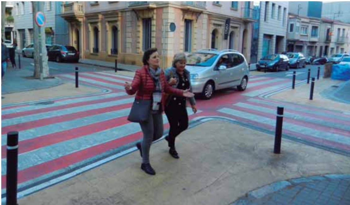
Tratamiento de intersección con pintura y bolardos para el calmado del tráfico y mejora del cruce peatonal en Sabadell.
