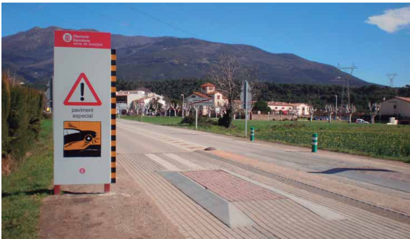
Almohada en el acceso a una travesía.
