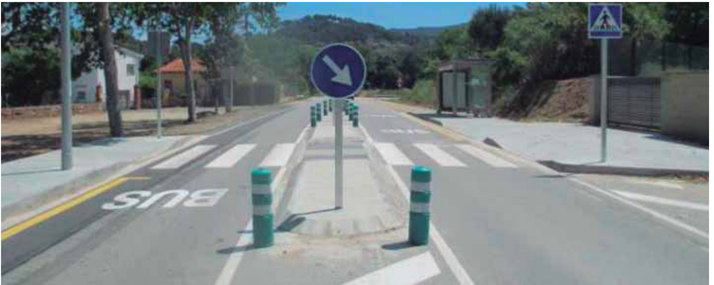
Parada de bus sin posibilidad de adelantamiento por parte de otros vehículos.
