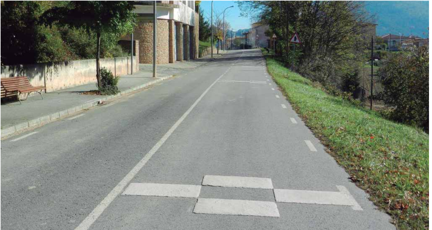
Elementos transversales de alerta.
