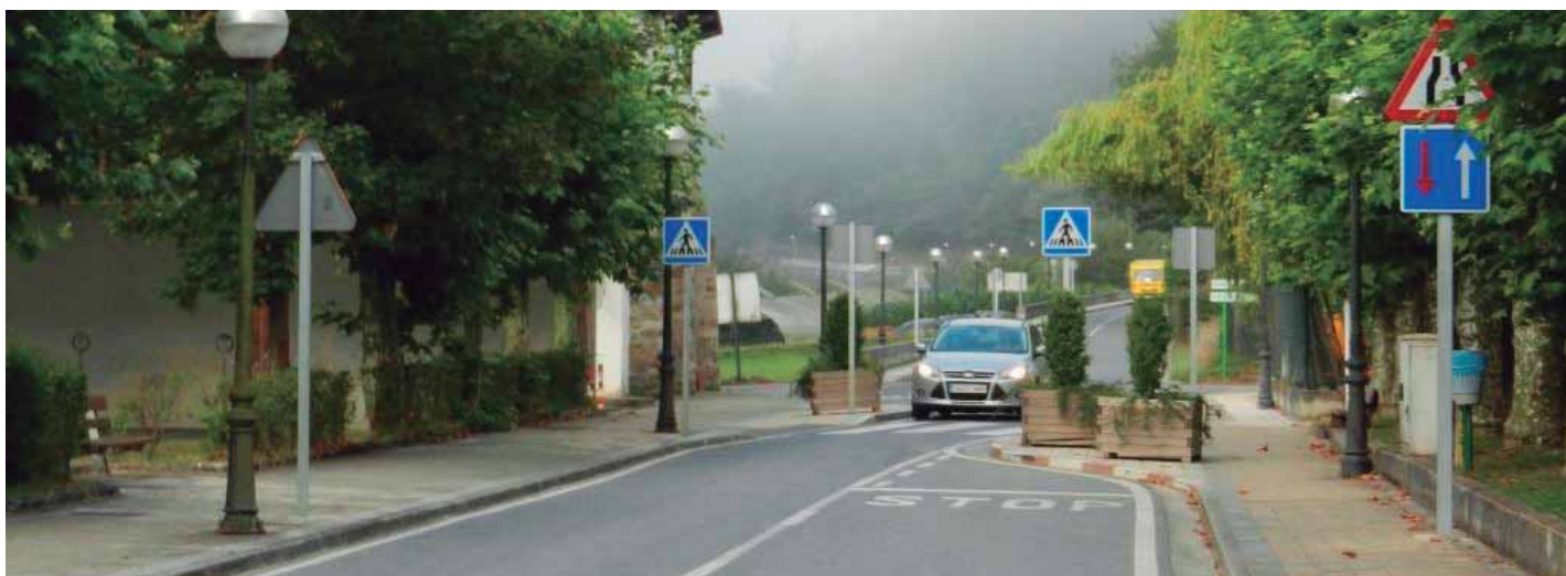
Estrechamiento con paso alterno como elemento reductor de velocidad.
