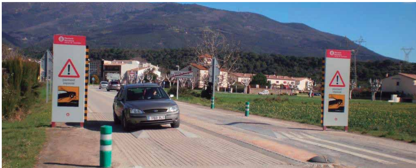
Ejemplo de “puerta de entrada” a una travesía combinando estrechamiento, señalización y almohadas de amortiguación de la velocidad en un núcleo urbano de Barcelona.
