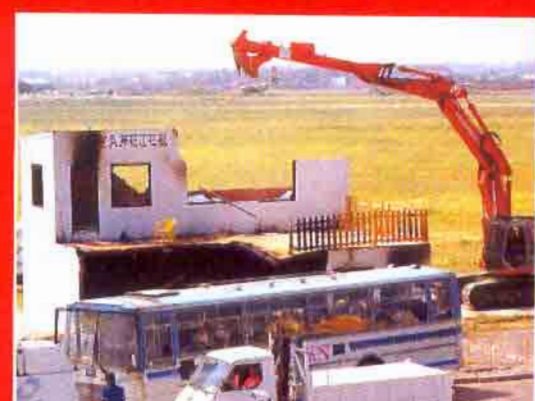
El estado del edificio afectado aconseja su demolición. Un enorme brazo mecánico se ocupa de ello.
