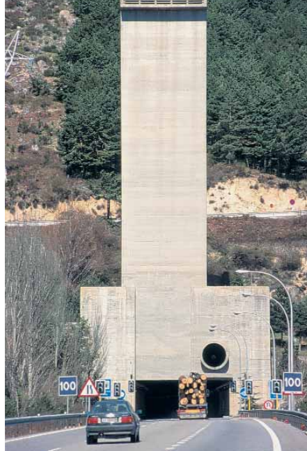
DE ORO. El equipamiento de los túneles y la señalización inteligente encaren mucho las carreteras.
