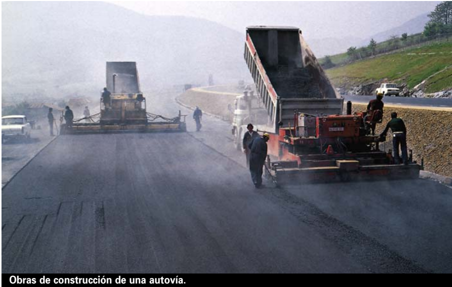
Obras de construcción de una autovía.
