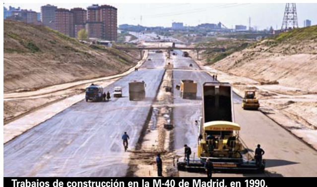
Trabajos de construcción en la M-40 de Madrid, en 1990.
