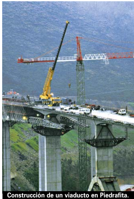
Construcción de un viaducto en Piedrafita.
