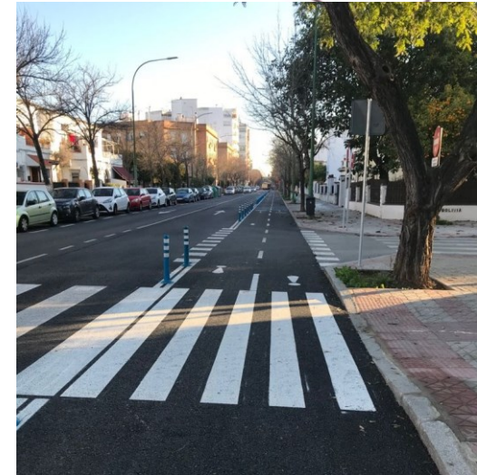
Vía ciclista en calzada en Sevilla
