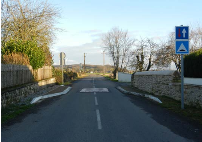
Estrechamiento de calzada y almohada central en el inicio de una travesía en Lay-Lamidou (Francia).
