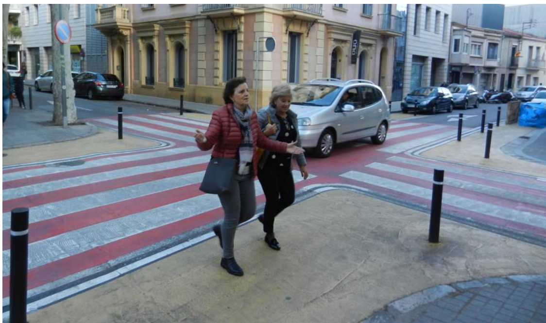
Tratamiento de intersección con pintura y bolardos para el calmado del tráfico y mejora del cruce peatonal en Sabadell.
