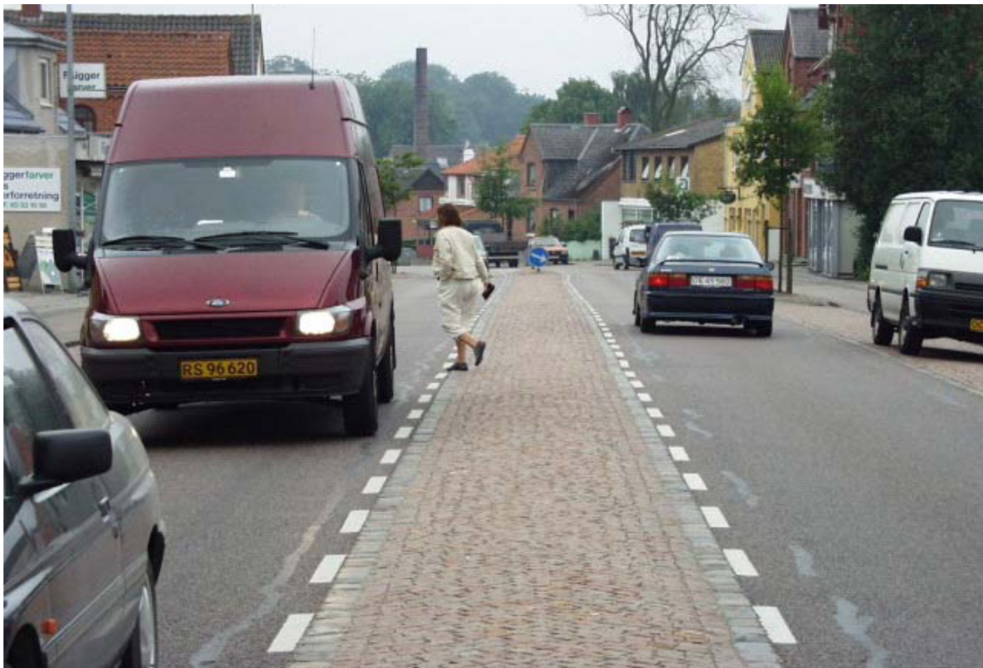
Permeabilización transversal de una travesía en Dinamarca.
