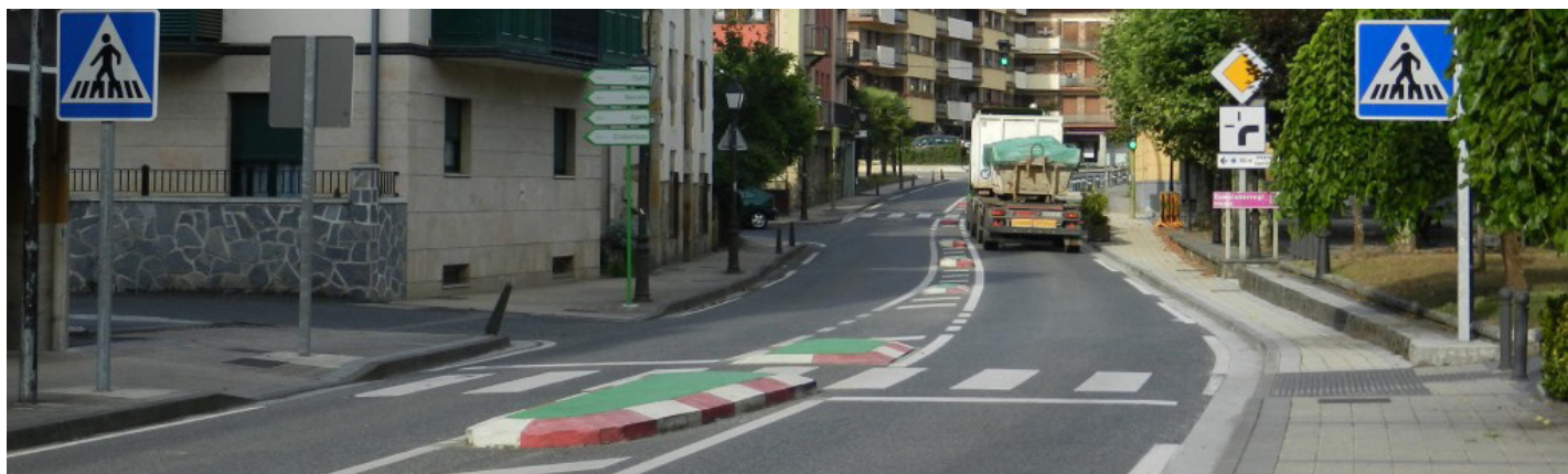
Estrechamiento mediante pintura y refugios peatonales.
