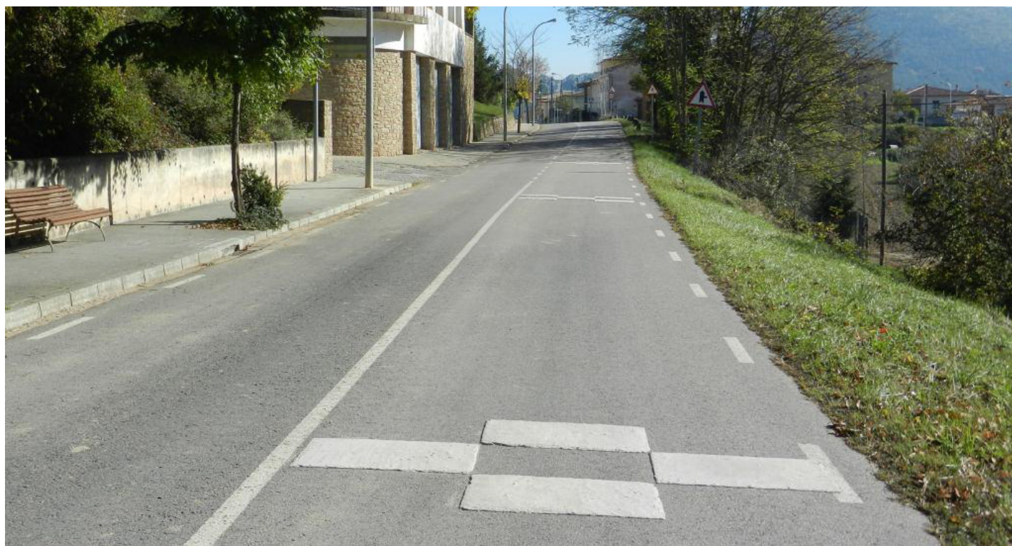
Elementos transversales de alerta.
