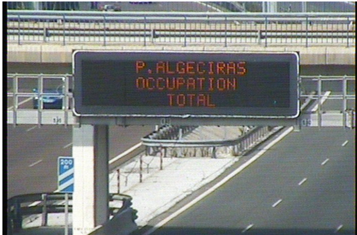
Ilustración 2: Ejemplo de difusión de mensajes en PMV para la gestión de riesgos asociados al tráfico (Operación Paso del Estrecho – DGT).
