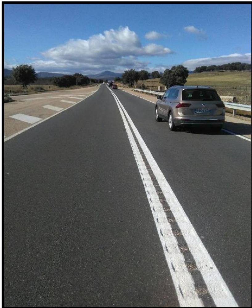
Fotografía 6: M-607 (Madrid) – GSLF de separación de sentidos en marca vial.
