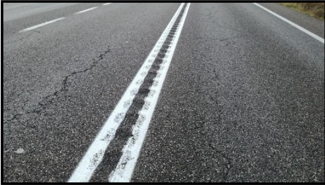
Fotografía 5: N-240 (Jueda – Lleida) - GSLF de separación de sentidos entre marcas viales tipo paralelogramo.
