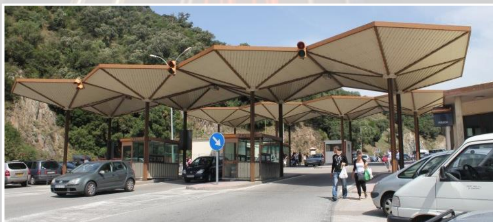
Ilustración 6 Le Perthus España - Puesto Fronterizo de Francia
